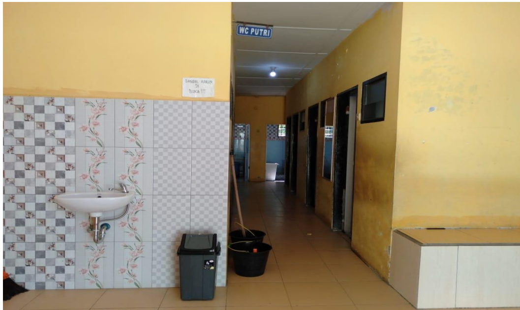
8. Toilet Tampak dari Luar Rehab, dan pengecatan dengan menggunakan dana BOS
