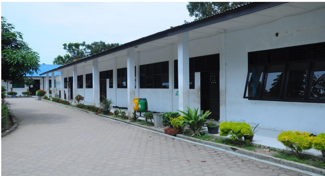
7. Ruang Kelas Tampak Luar sebelum di renovasi
