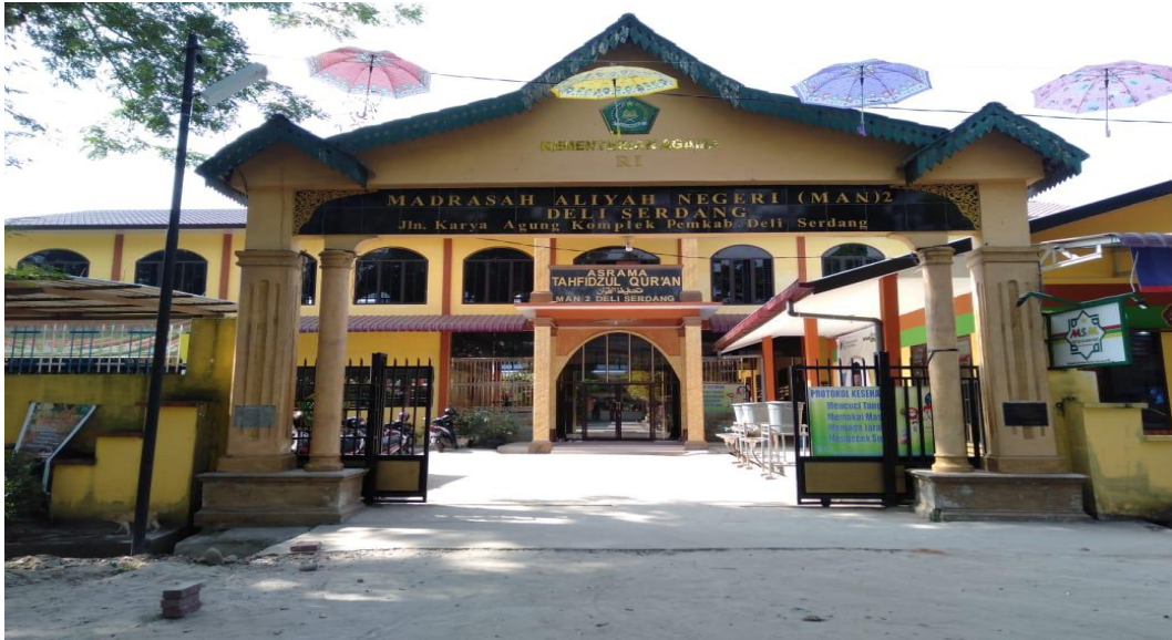
1. Gedung Madrasah Sesudah di renovasi Pintu Gerbang di bangun dengan menggunakan dana BOS
