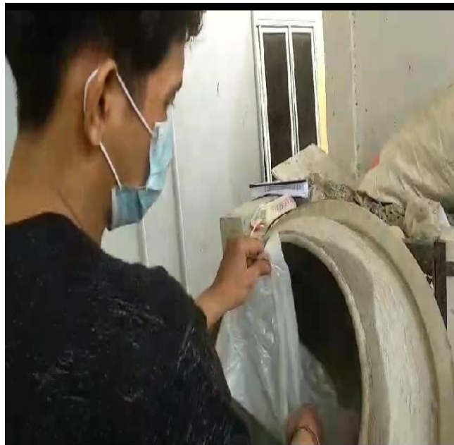
Gambar L-16 Proses Pembuatan Adukan Beton
