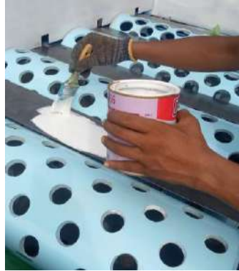
Gambar 4.82. Pengecatan menggunakan kuas
