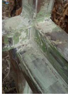
Gambar 4.79. Pendempulan pada kerangka
