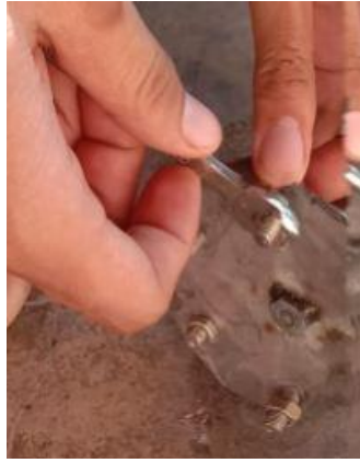
Gambar 4.7 Pengetatan dengan baut dan mur
