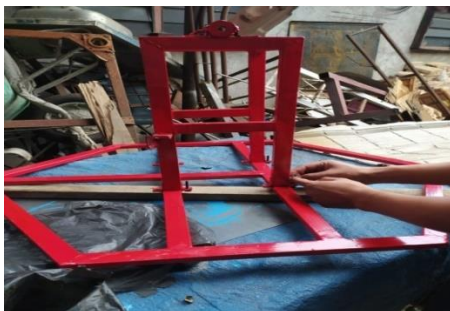
Gambar 4.38 pemasangan kerangka ats dengan bawah
