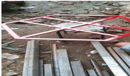
Gambar 4.37 pengecatan
