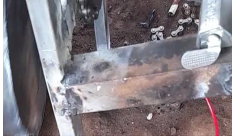
Gambar 4. 35 pembuatan dudukan generator
