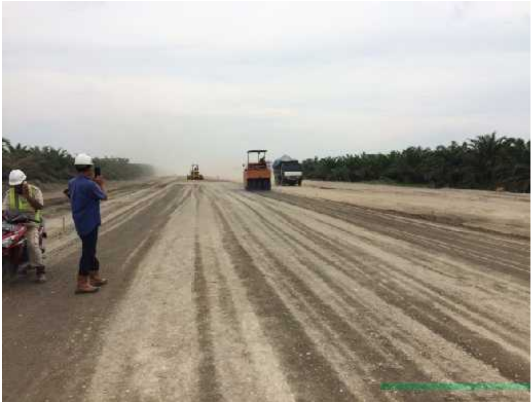
Gambar L.5: Penghamparan agregat/base kelas a (Arah Megawati).
