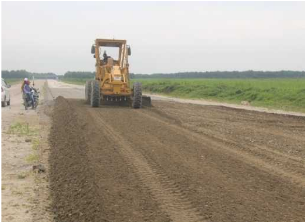
Gambar L.4: Penghamparan agregat/base kelas a (Arah Helvetia).
