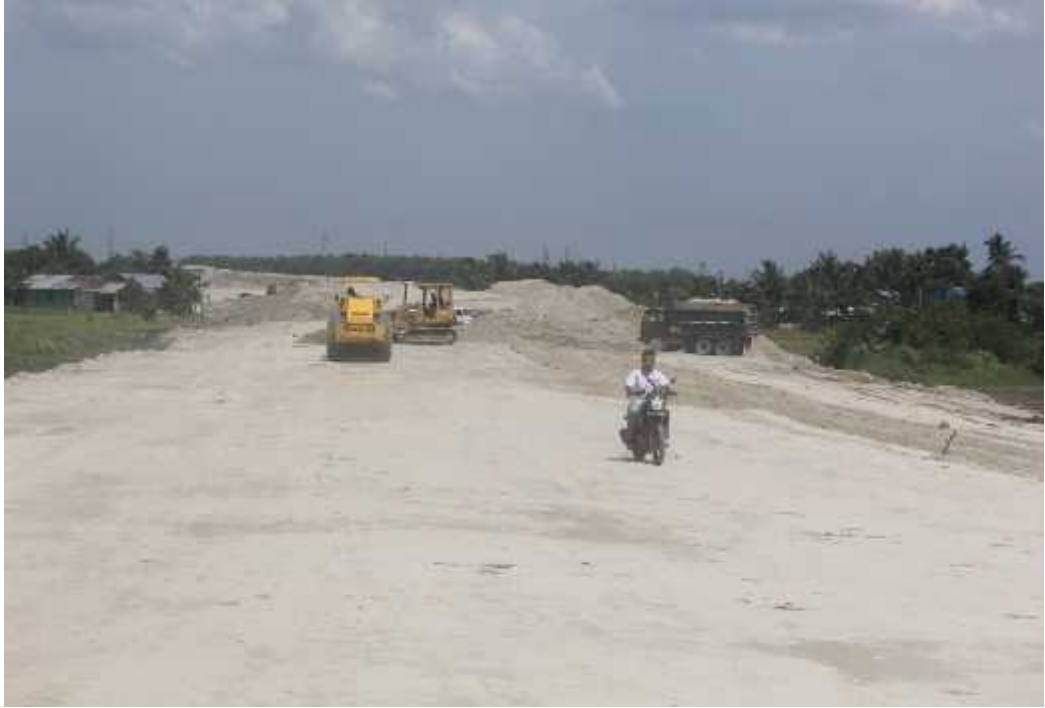
Gambar L.3: Pekerjaan timbunan Desa Payabakung.
