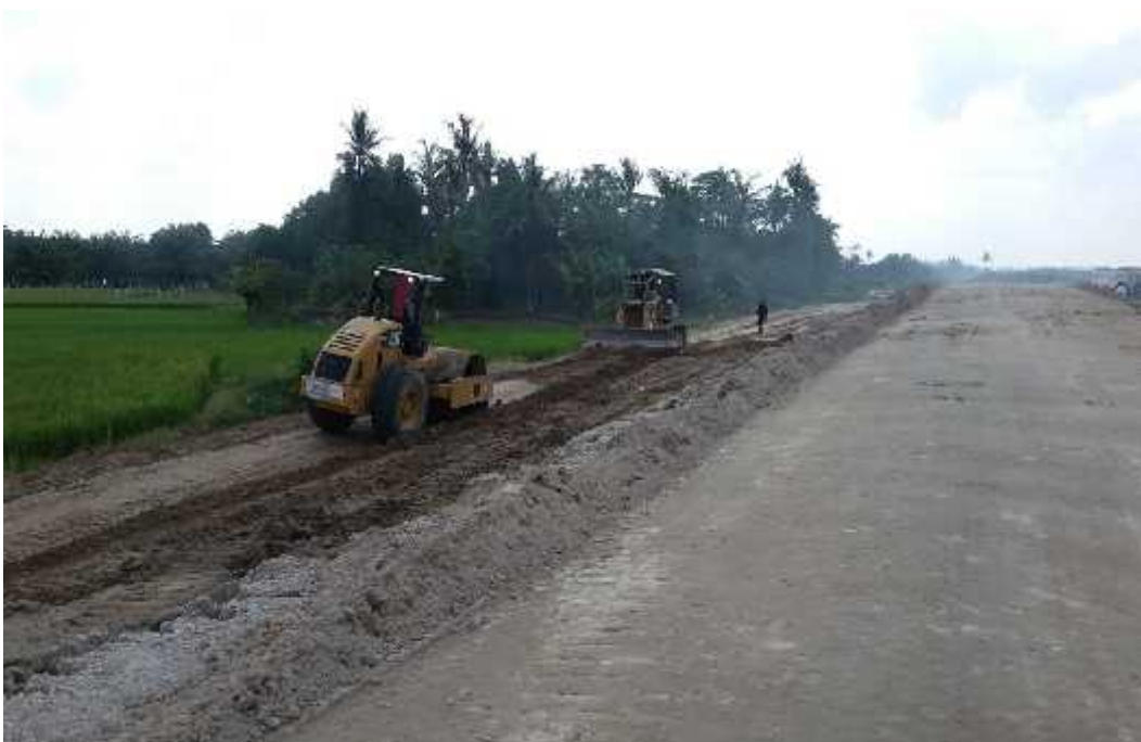
Gambar L.2: Seksi 3 pekerjaan timbunan (Arah Megawati).
