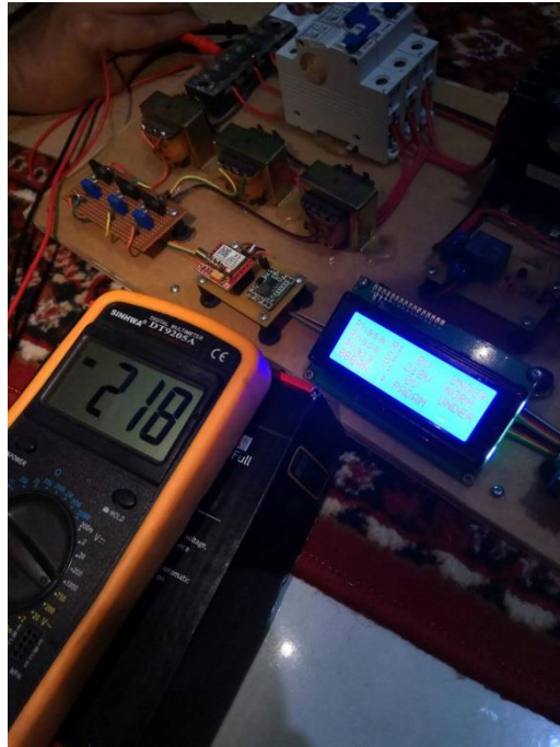
Gambar 4.15 Pengukuran Fasa S PLN
