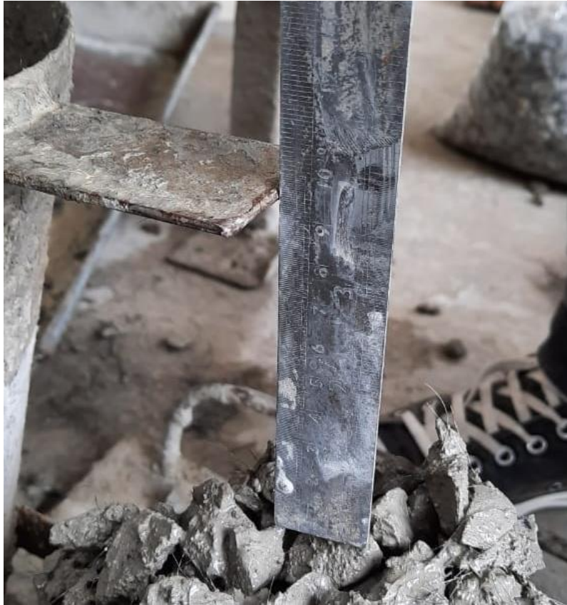
Gambar L5: Dokumentasi proses pengecoran pembuatan benda uji penelitian
