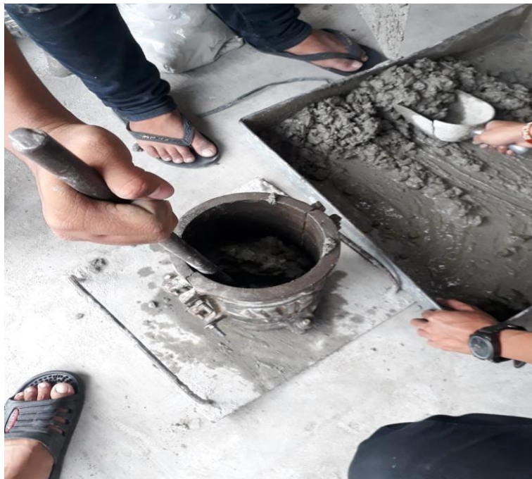
Gambar L6: Dokumentasi proses pencetakan benda uji penelitian
