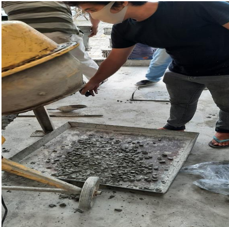
Gambar L4: Dokumentasi proses pengecoran pembuatan benda uji penelitian
