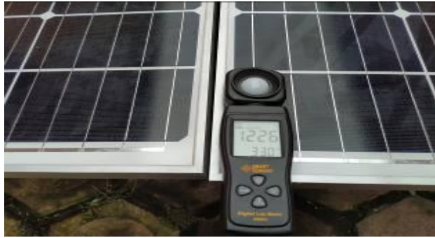
Gambar 4.7 Hasil Pengukuran Intensitas cahaya menggunakan lux meter
