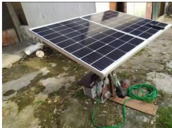
Gambar 4.2 Panel surya yang diletakkan pada kerangka penyangga.
