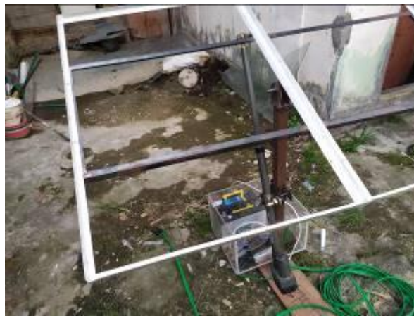
Gambar 4.1 Rangka penyangga panel surya
