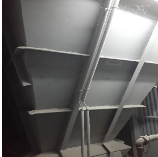
Gambar 2.16. Hopper/Pengumpan
