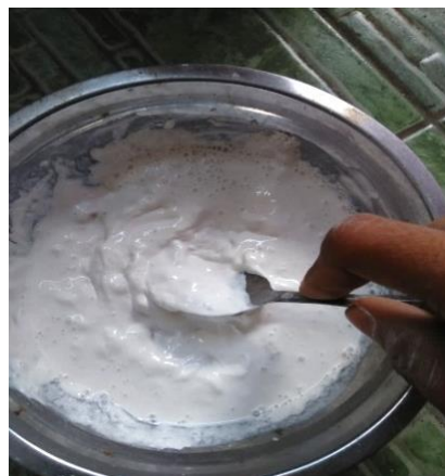
Gambar 3.6 Pencampuran plaster dengan air
