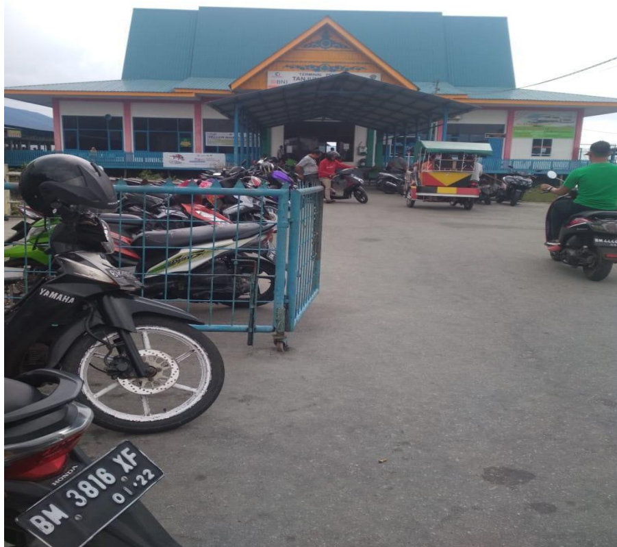
Gambar L2 : Areal Parkir Kendaraan di Pelabuhan
