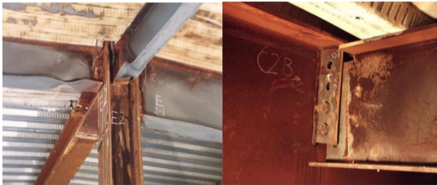
Gambar 2.1: Kegagalan sambungan baja
