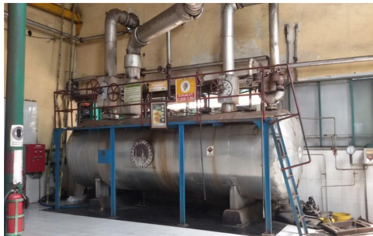
Gambar 2.30 Back Presseur Vessel (BPV)
