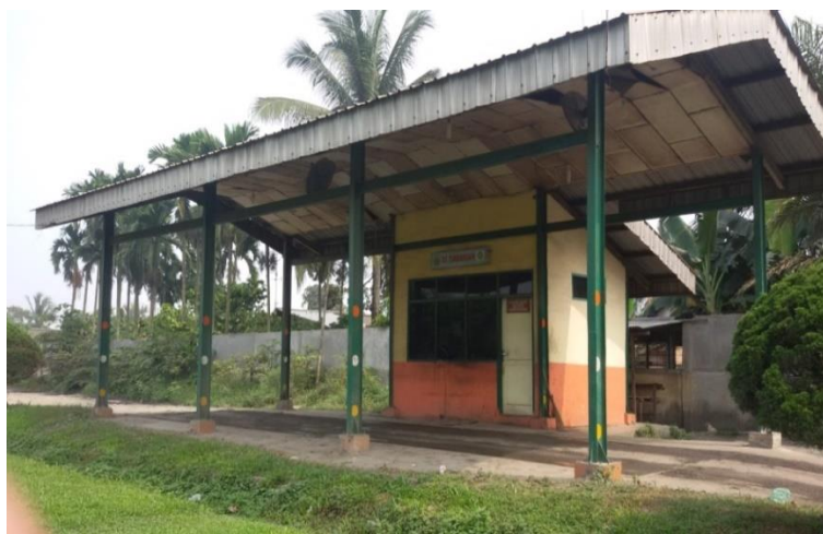
Gambar 2.16 Stasiun Penimbangan ( Weight Bridge )
