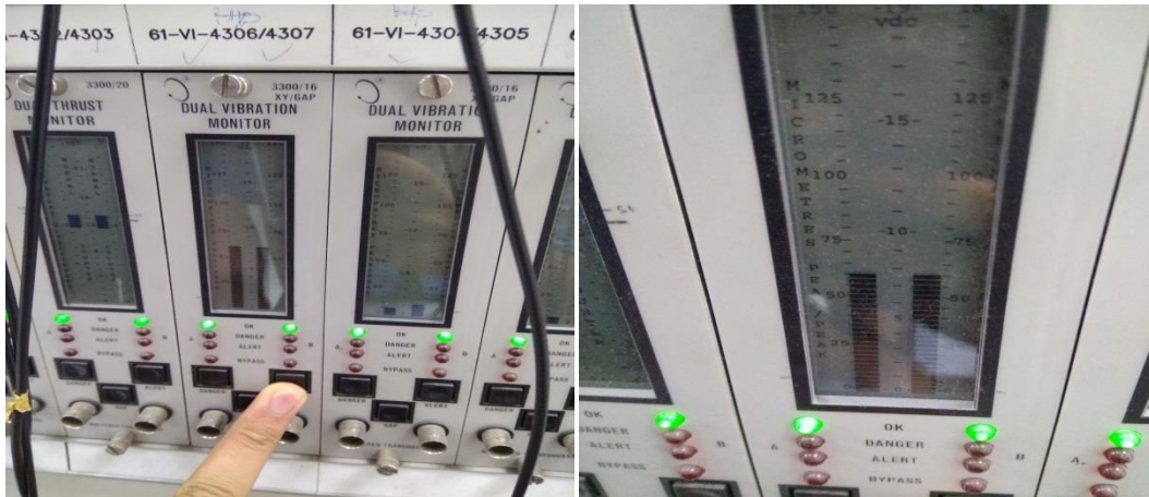
Gambar 4.3 Kondisi Axial Alert
