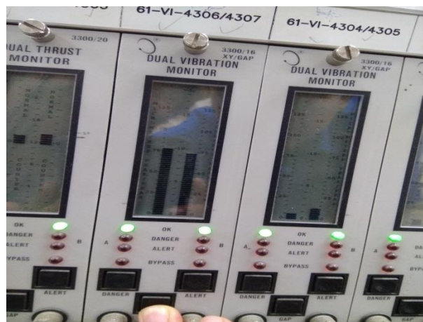
Gambar 4.2 Kondisi Axial normal
