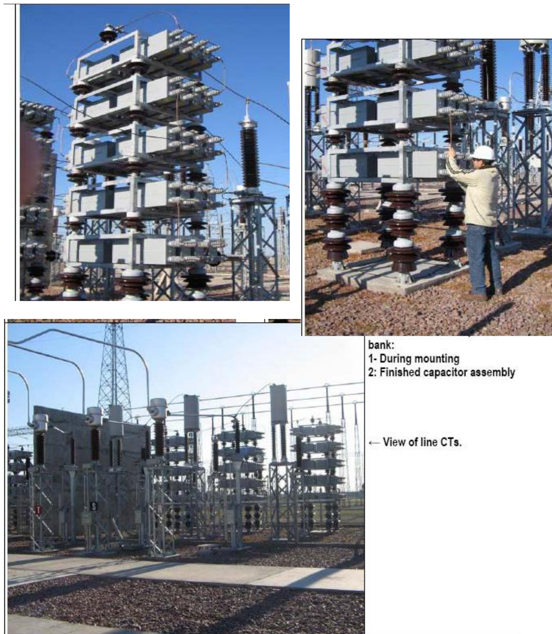
Gambar 3.8 Pemasangan kapasitor shunt pada sisi penerima (substation)
