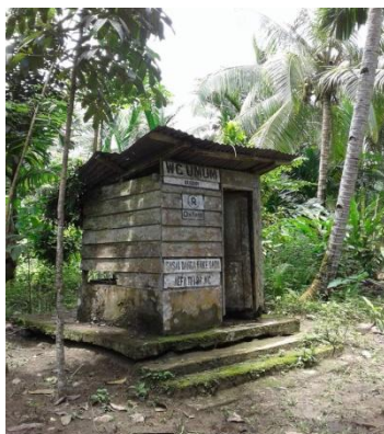
Keterangan : Dokumentasi keadaan MCK atau WC Umum di Desa Humene.
