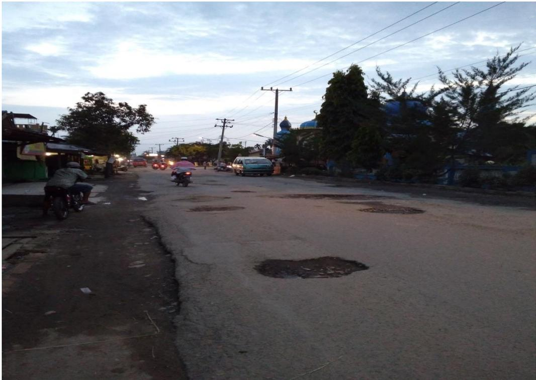
Gambar L.4: Menghitung kerusakan jalan di jalan Rimo–Singkil.
