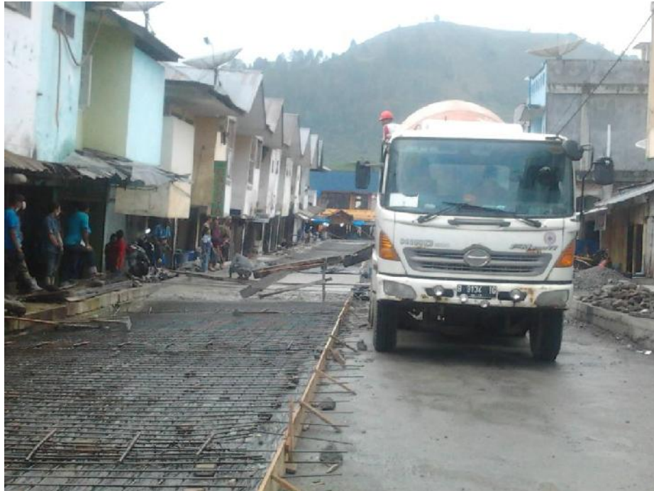
Gambar L5: Pengangkutan adukan beton menggunakan truck molen
