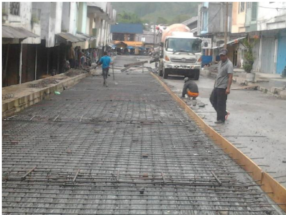
Gambar L2: Pemasangan tie bar dan dowel
