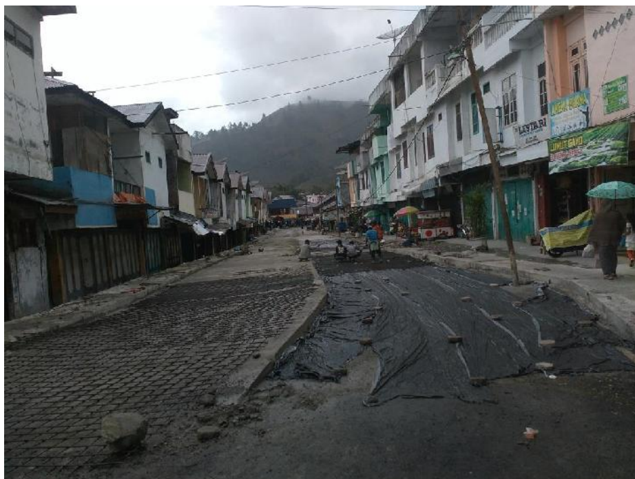
Gambar L6: Pemasangan lapis kedap air
