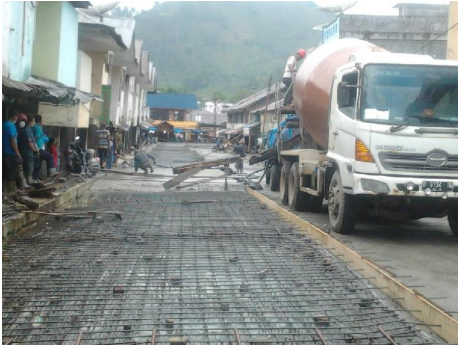
Gambar L3: Pengecoran campuran beton semen
