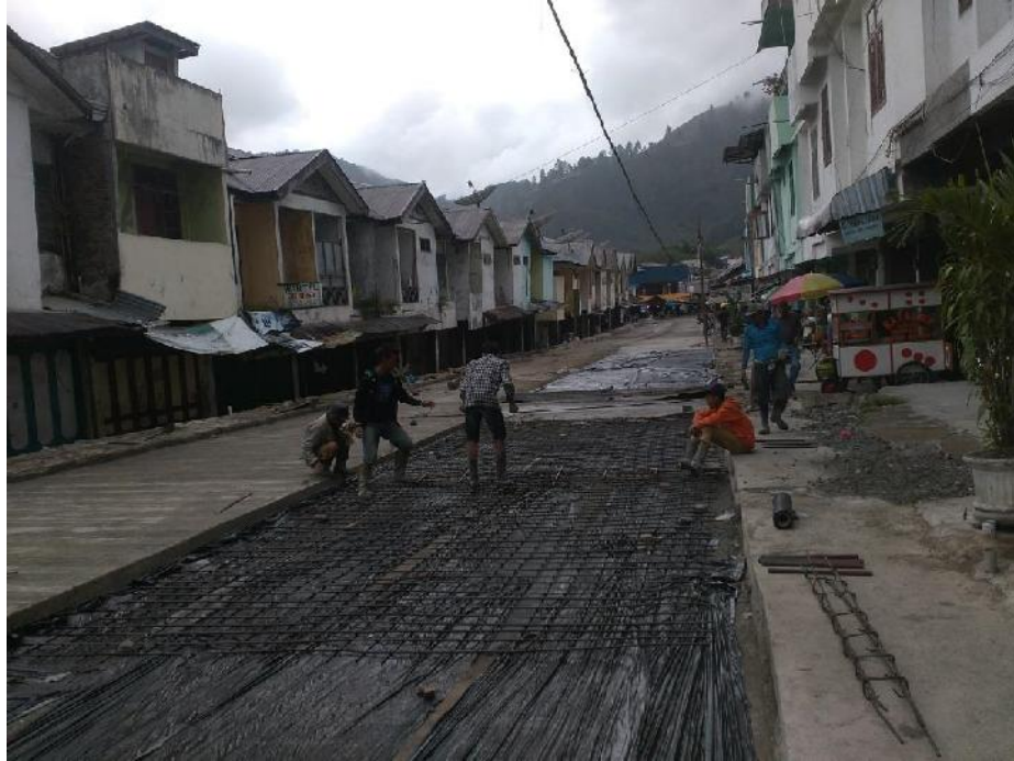
Gambar L1: Proses pemasangan tulangan
