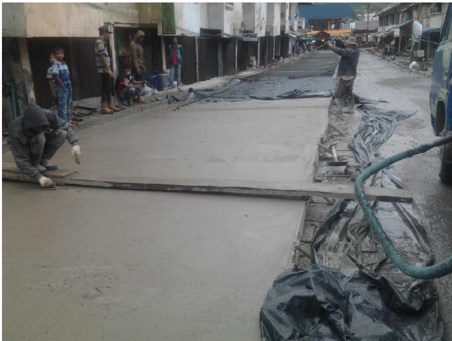
Gambar L4: Meratakan hamparan campuran beton semen
