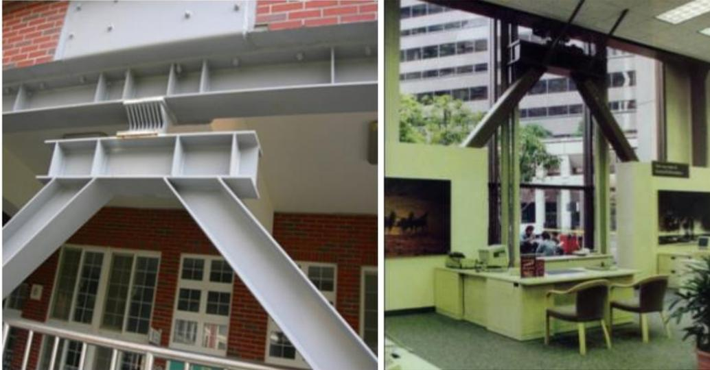
Gambar 2.18: Aplikasi metallic yielding damper pada struktur (FEMA,2004)
