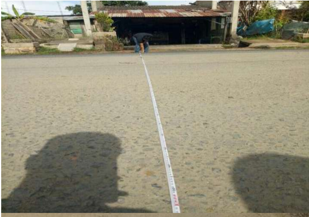
Gambar L. 3: Pengukuran lebar jalan sesudah pelebaran.
