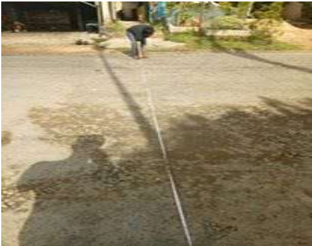
Gambar L. 2: Pengukuran jalan sebelum pelebaran.
