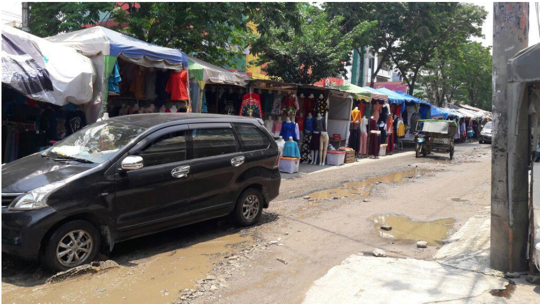
Gambar L. 1.6: Kondisi fisik ruas Jalan Aksara.
