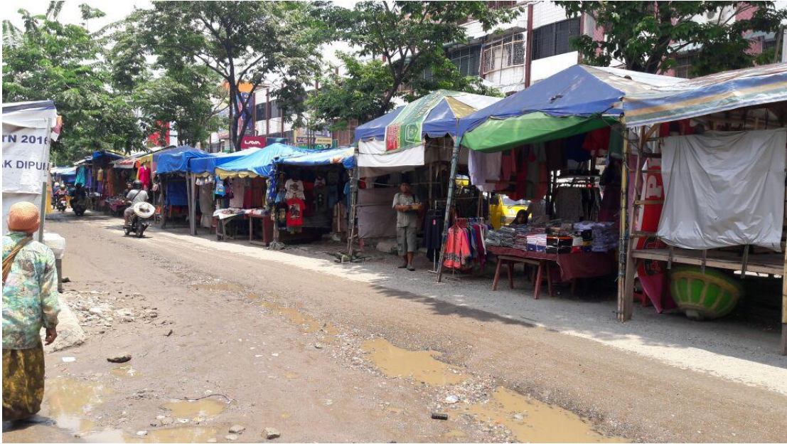
Gambar L. 1.5: Kondisi fisik ruas Jalan Aksara.
