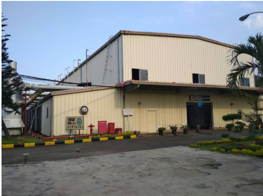
GAMBAR GEDUNG PEMBANGKIT LISTRIK TENAGA DIESEL TITI KUNING.
