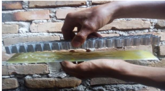
Gambar 4.18 Pemasangan Skin ukuran 6 mm
