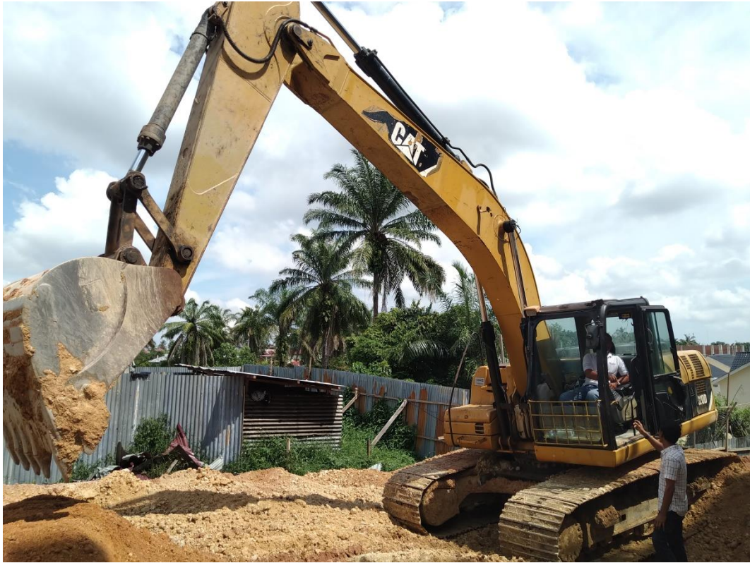
Gambar L1 : Alat berat excavator
