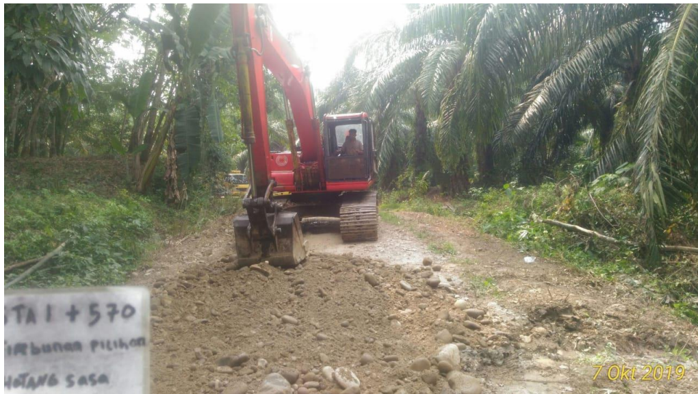
Gambar L1: Alat Berat Excavator
