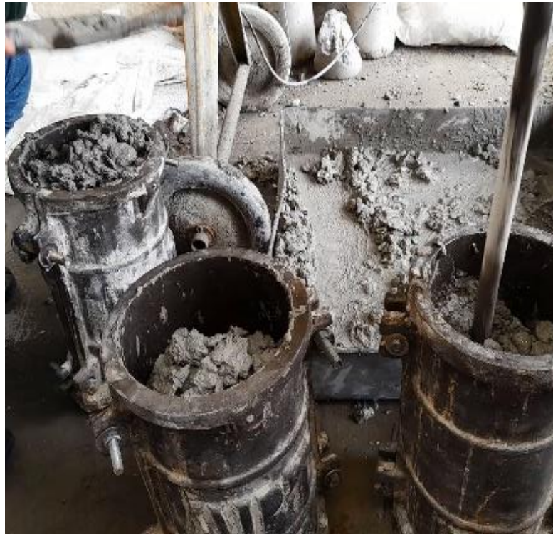
Gambar L-3 Perojokan adukan beton dicetakan
