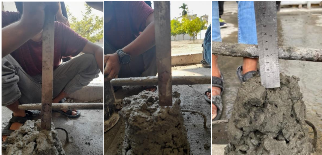
Gambar L-2 Pengujian slump test
