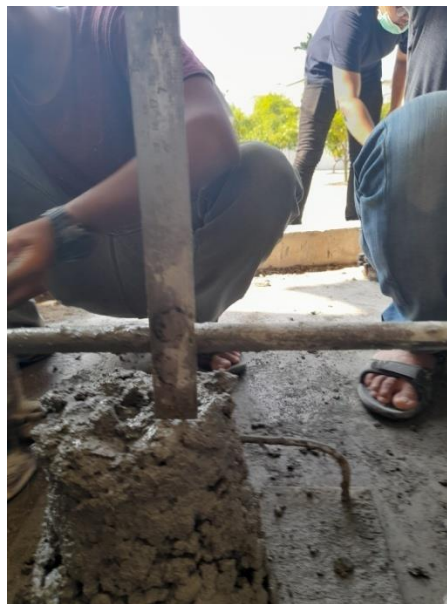
Gambar 3.35: Pengujian slump (kerucut Abram)
