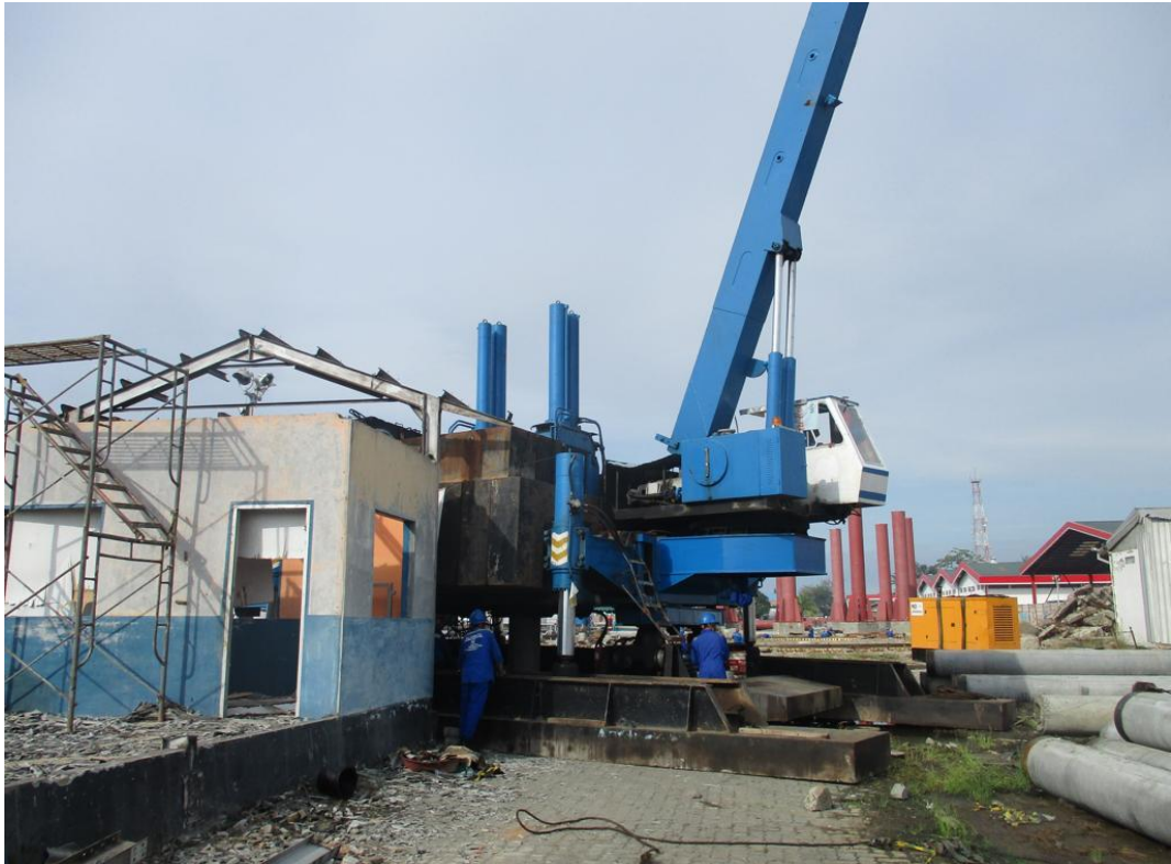
Gambar 3.5: Proses Pengangkatan Tiang Pancang
