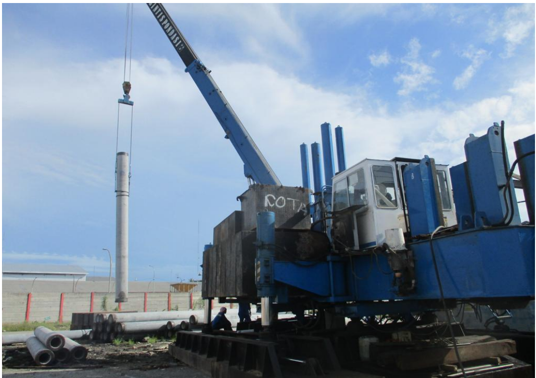
Gambar 3.6: Proses pengangkatan tiang pancang ke lokasi titik pemancangan
