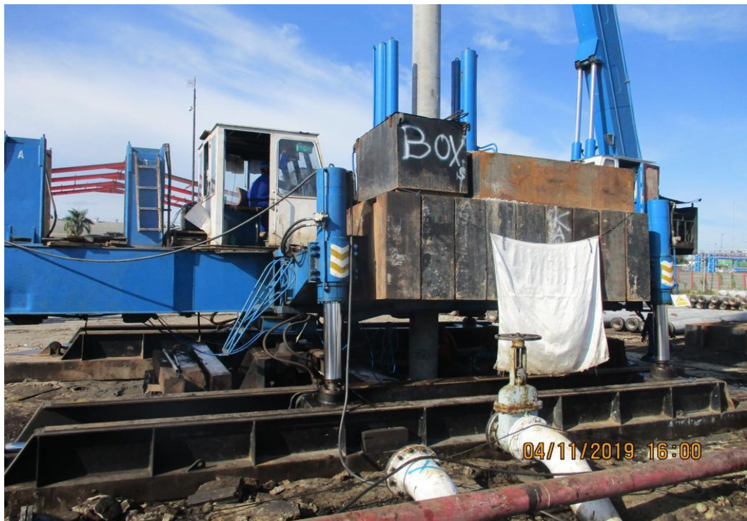
Gambar 3.4: Alat HSPD untuk pemancangan pondasi
