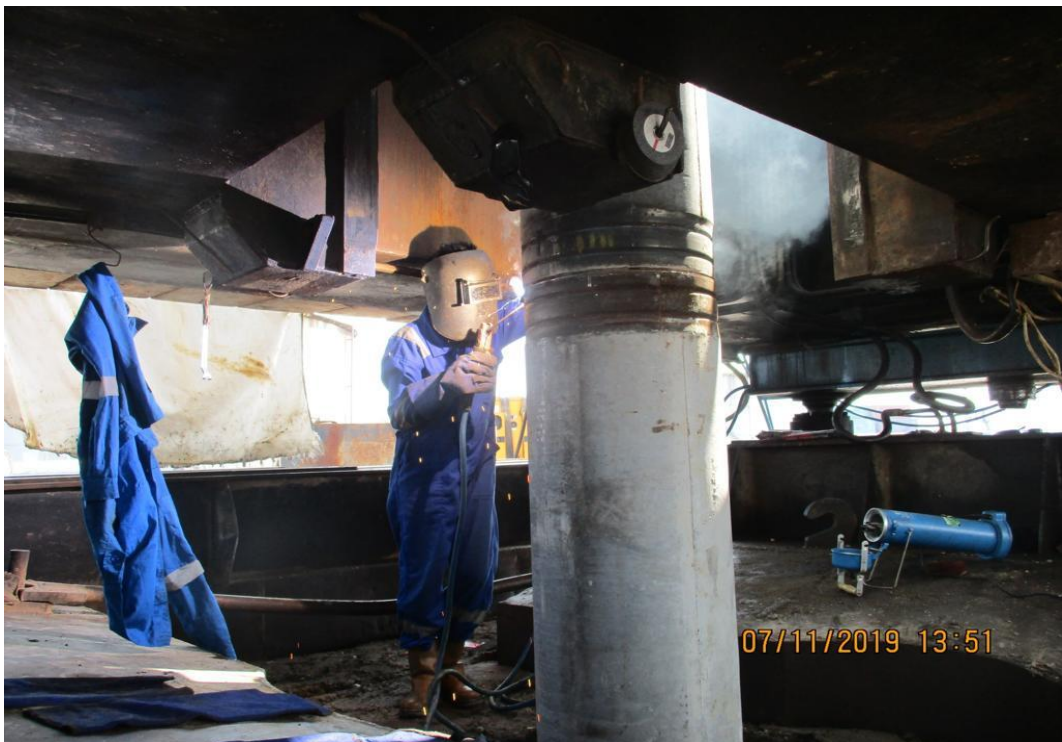
Gambar 3.8: Proses pengelasan pada tiang pancang
