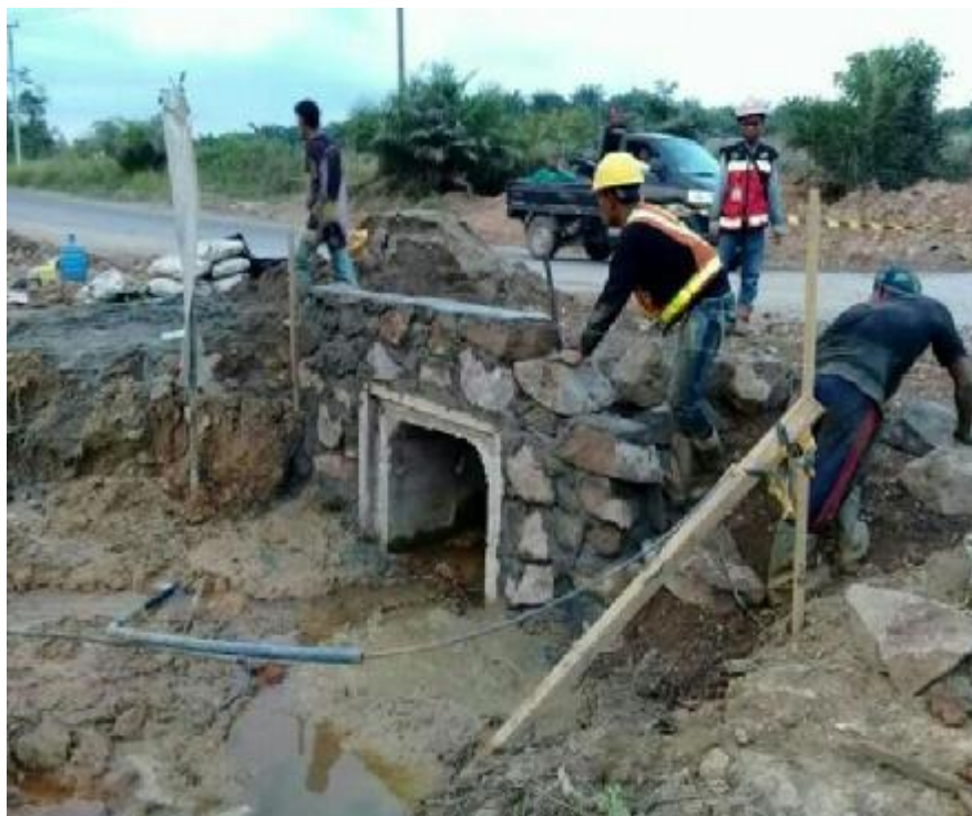
Gambar: Pembuatan Saluran Box Culvert.
