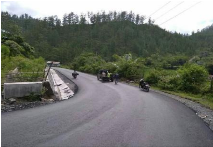
Gambar: Jalan Lintas Takengon – Uwaq .
