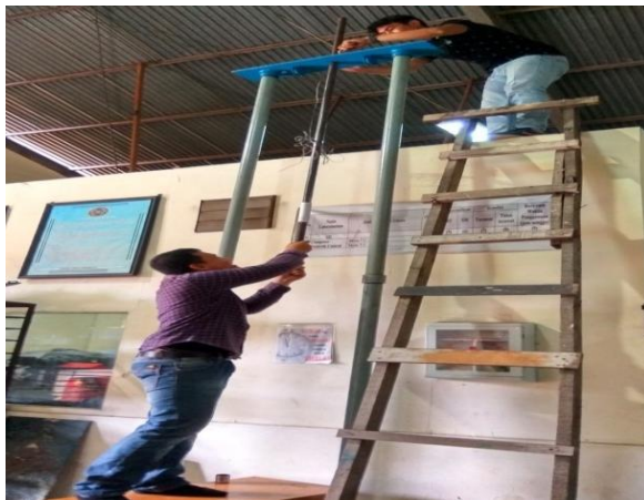
Gambar 3.13 Pemasangan Besi Baja Karbon
