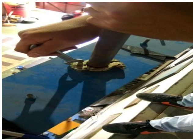
Gambar 3.14 Pemasangan Kelm Besi
