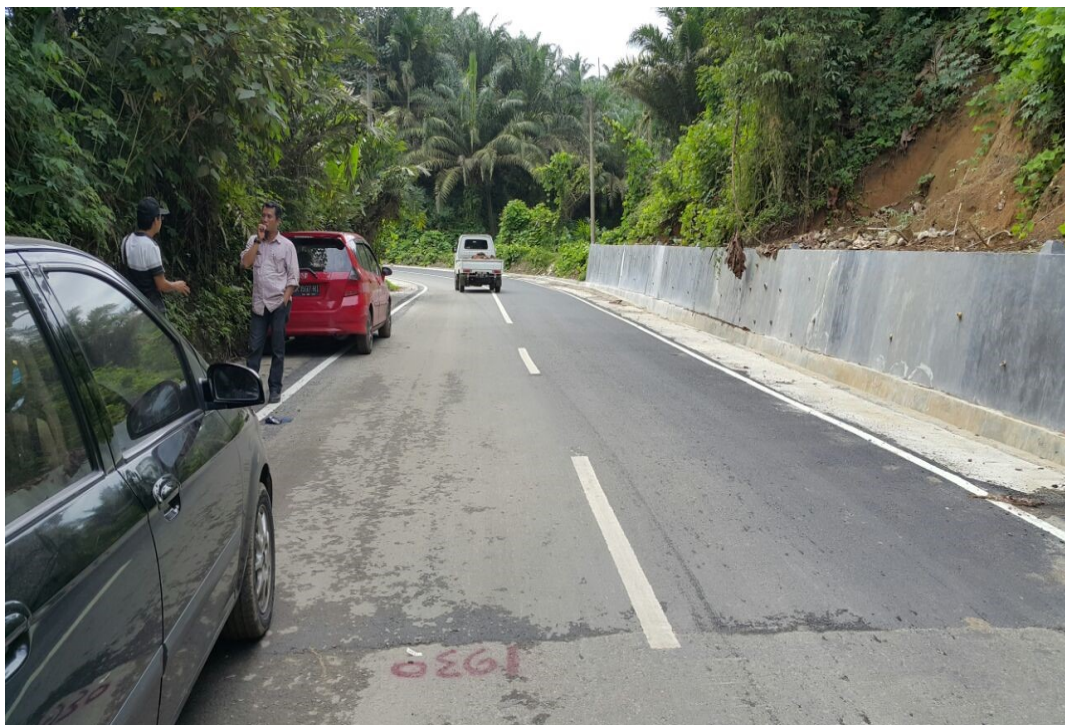
Gambar L2: STA 1 + 980 Batas akhir segmen perencanaan peningkatan jalan.
