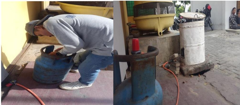
Gambar 3.28. Proses pemasangan regulator gas
