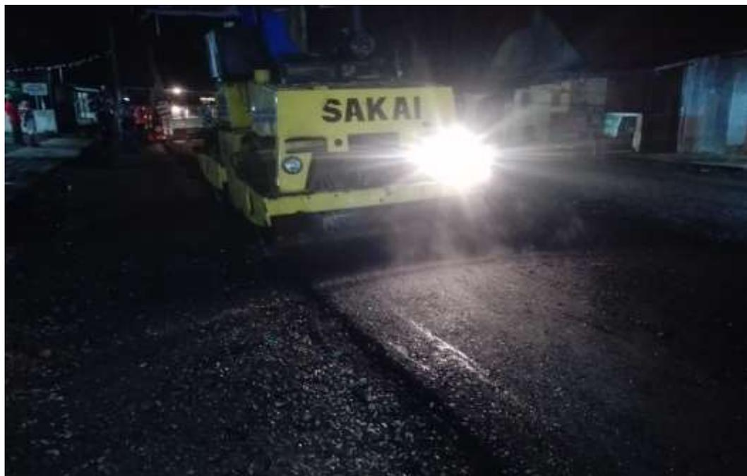
Gambar L.8: Proses pemadatan lapisan aspal (AC-BASE) menggunakan tandem roller.
