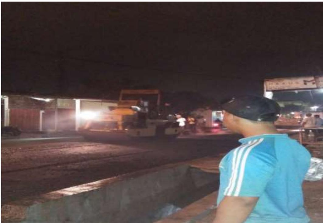
Gambar L.14: Proses pemadatan permukaan aspal (AC-WC).
