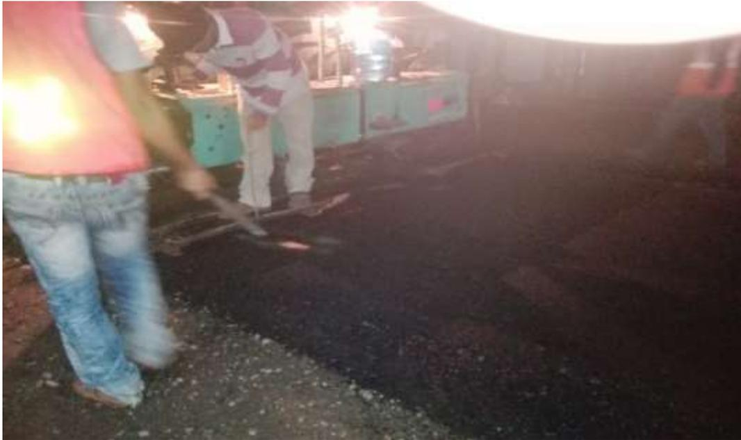
Gambar L.7: Menghitung ketinggian aspal setelah dihampar.
