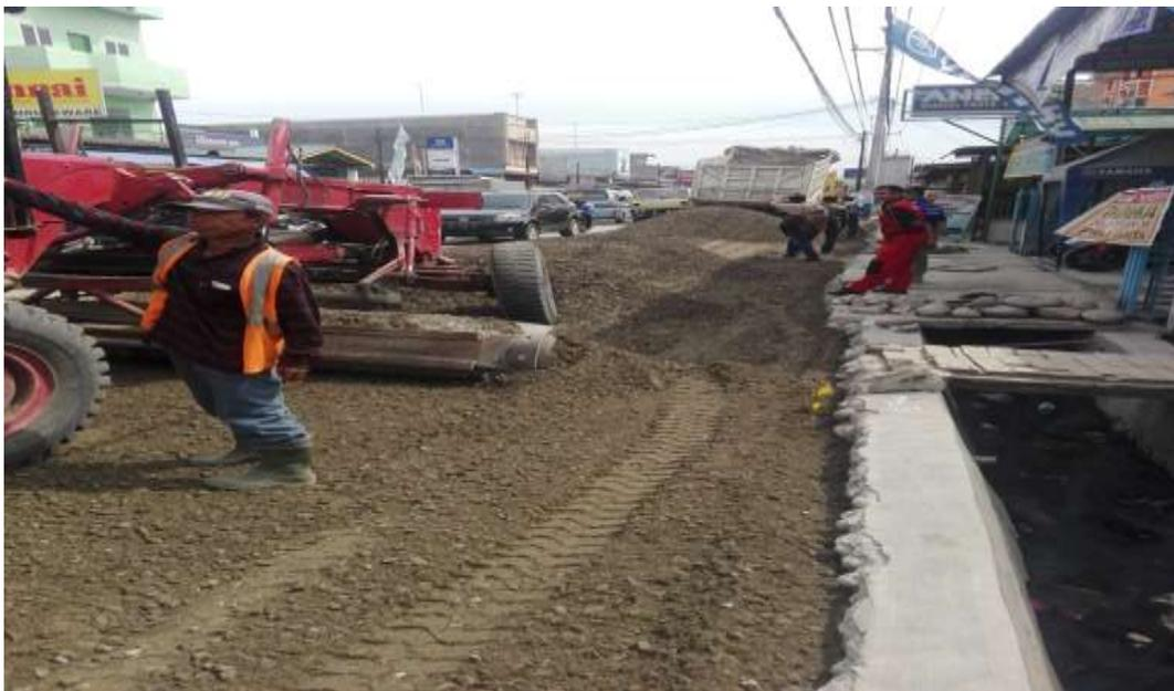
Gambar L.2: Proses meratakan agregat menggunakan alat motor grader.
