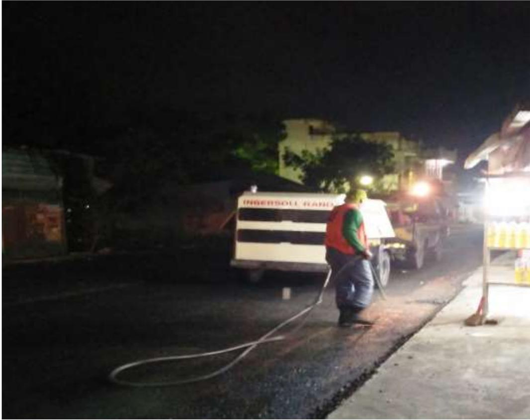
Gambar L.9: Proses pembersihan permukaan aspal (AC-BASE).
