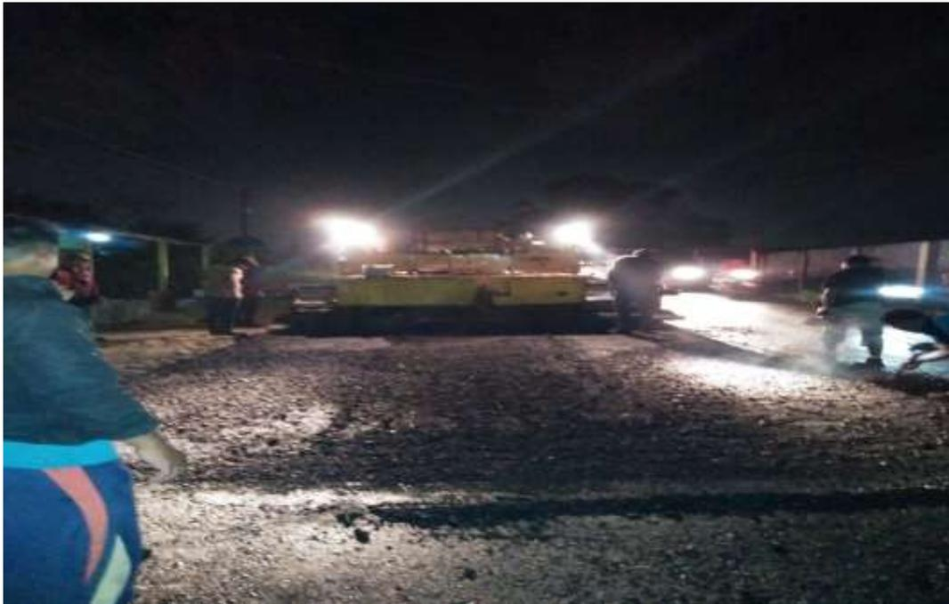
Gambar L.11: Proses penghampanan permukaan aspal (AC-BC).
