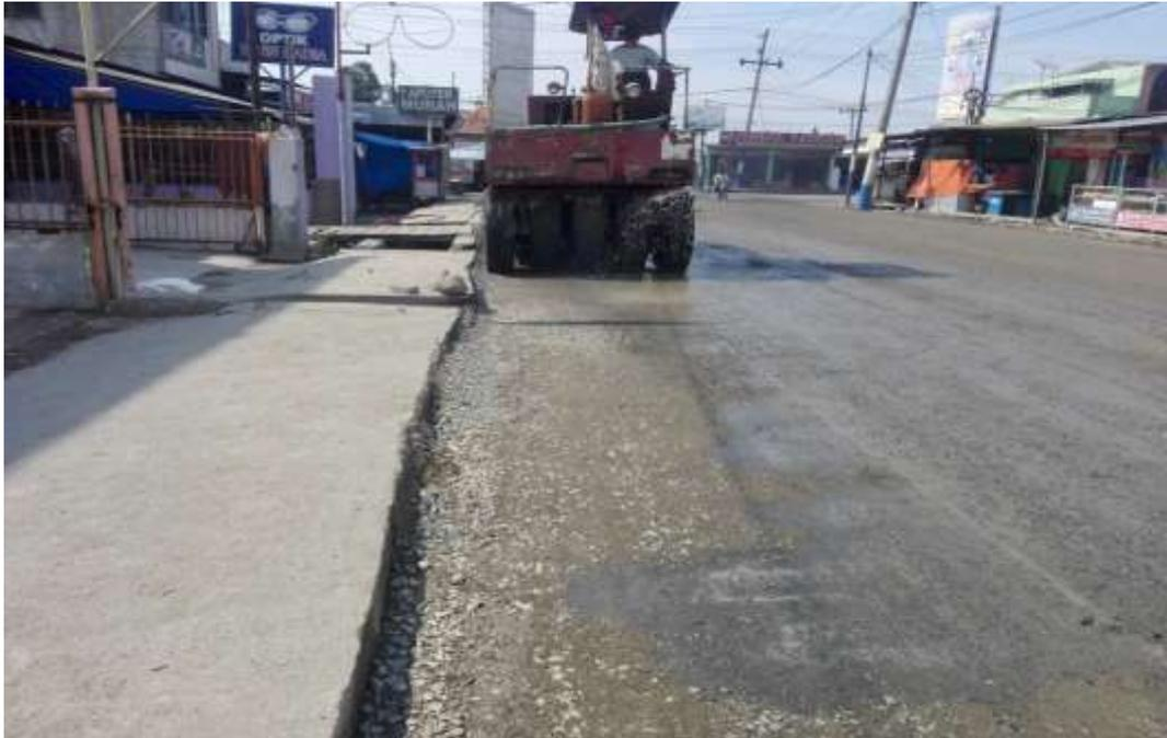
Gambar L.3: Proses pemadatan agregat menggunakan alat penumatic tire roller ( PTR ).
