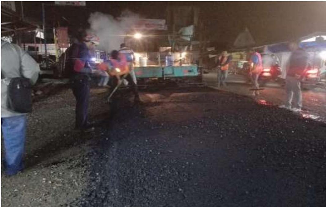
Gambar L.6: Proses penghambaran aspal menggunakan alat asphalt finisher.
