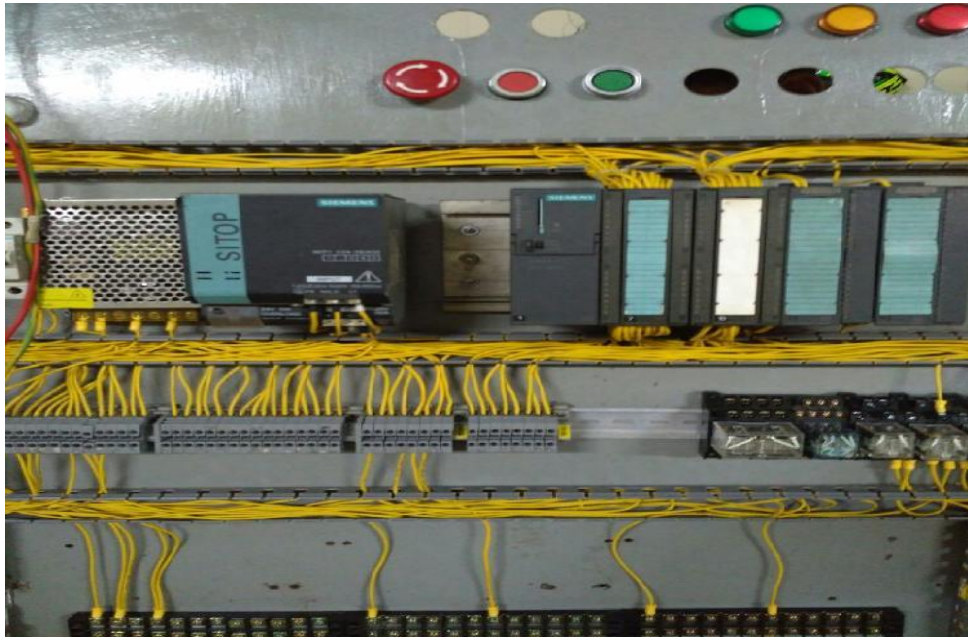
Gambar 4.4 Rangkaian PLC Siemens S7-300
