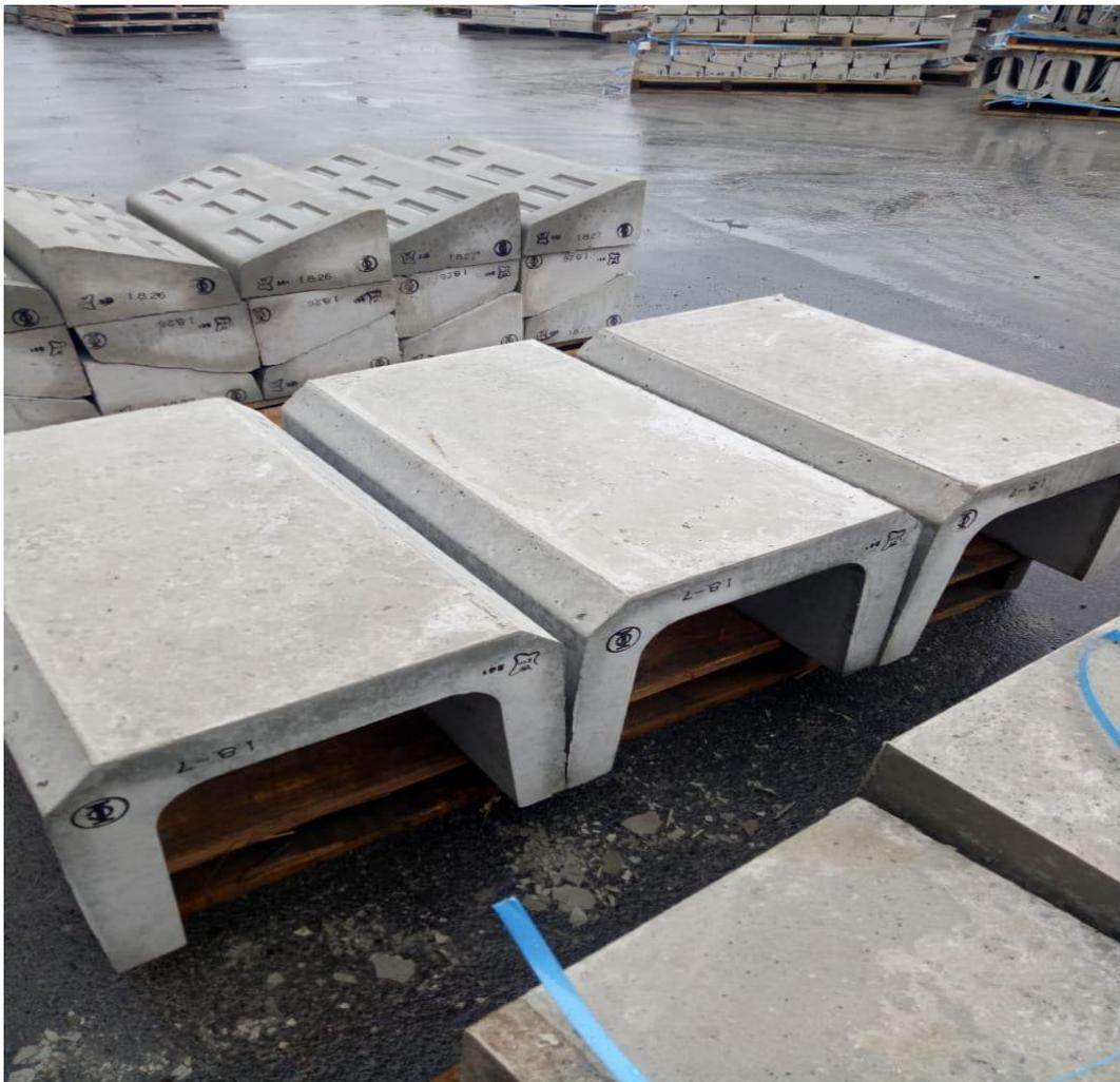
Gambar 4.21: *Precast U Ditch* yang telah ditumpukkan di area gudang.
