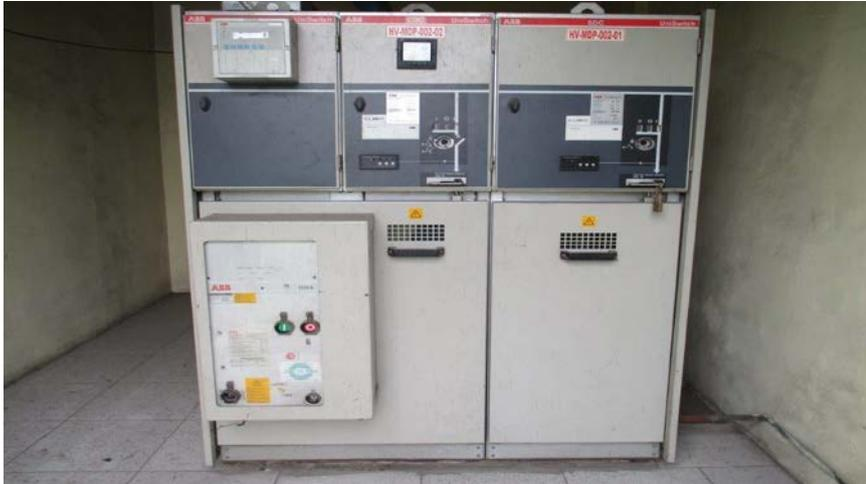
Gambar 3.3 Cubicle Tegangan Menengah
