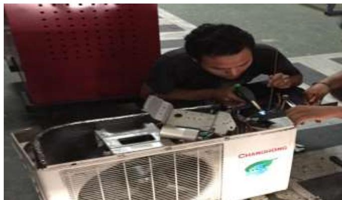
Gambar 4.19 Pemasangan Sensor Pada Jalur *Refrigerant*
