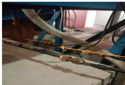
Gambar 4.24. Sensor Suhu Keluar Kompresor
