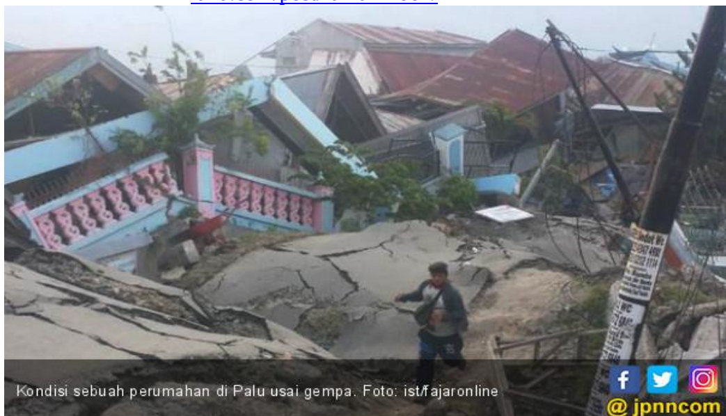
Gambar 1.2 kondisi perumahan di perumnas Balaroa, Palu yang porak poranda akibat gempa. Sumber https://m.jpnn.com/news/gempa-membalikkan-perumnas-balaroa-palu-oh-mayat-ibu-itu
