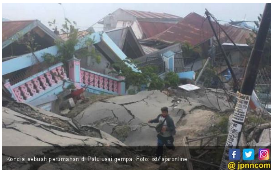
1.1 Gambar kondisi perumahan di perumnas Balaroa, Palu yang porak poranda akibat gempa. Sumber https://m.jpnn.com/news/gempa-membalikkan-perumnas-balaroa-palu-oh-mayat-ibu-itu
