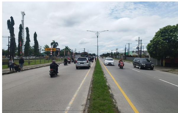
Gambar 3.3 Foto Kondisi Jalan Dari Rute Tanjung Morawa – Amplas
