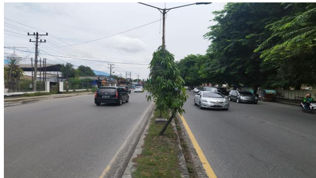
Gambar 3.3: Foto Kondisi Jalan Dari Rute Tanjung Morawa – Amplas
