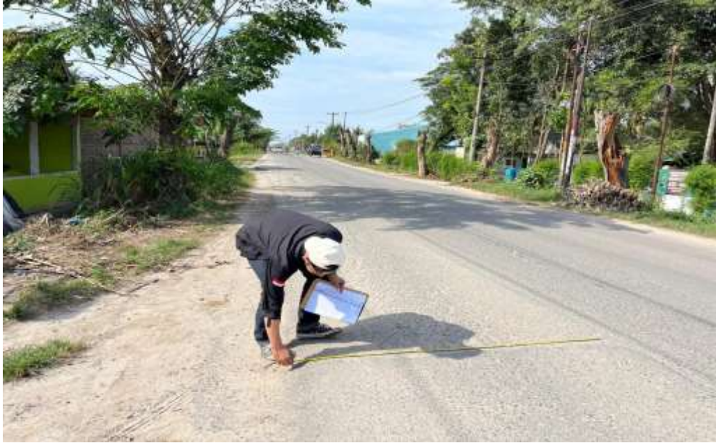
Gambar 3 Menghitung Kerusakan Jalan Jenis Tambalan
