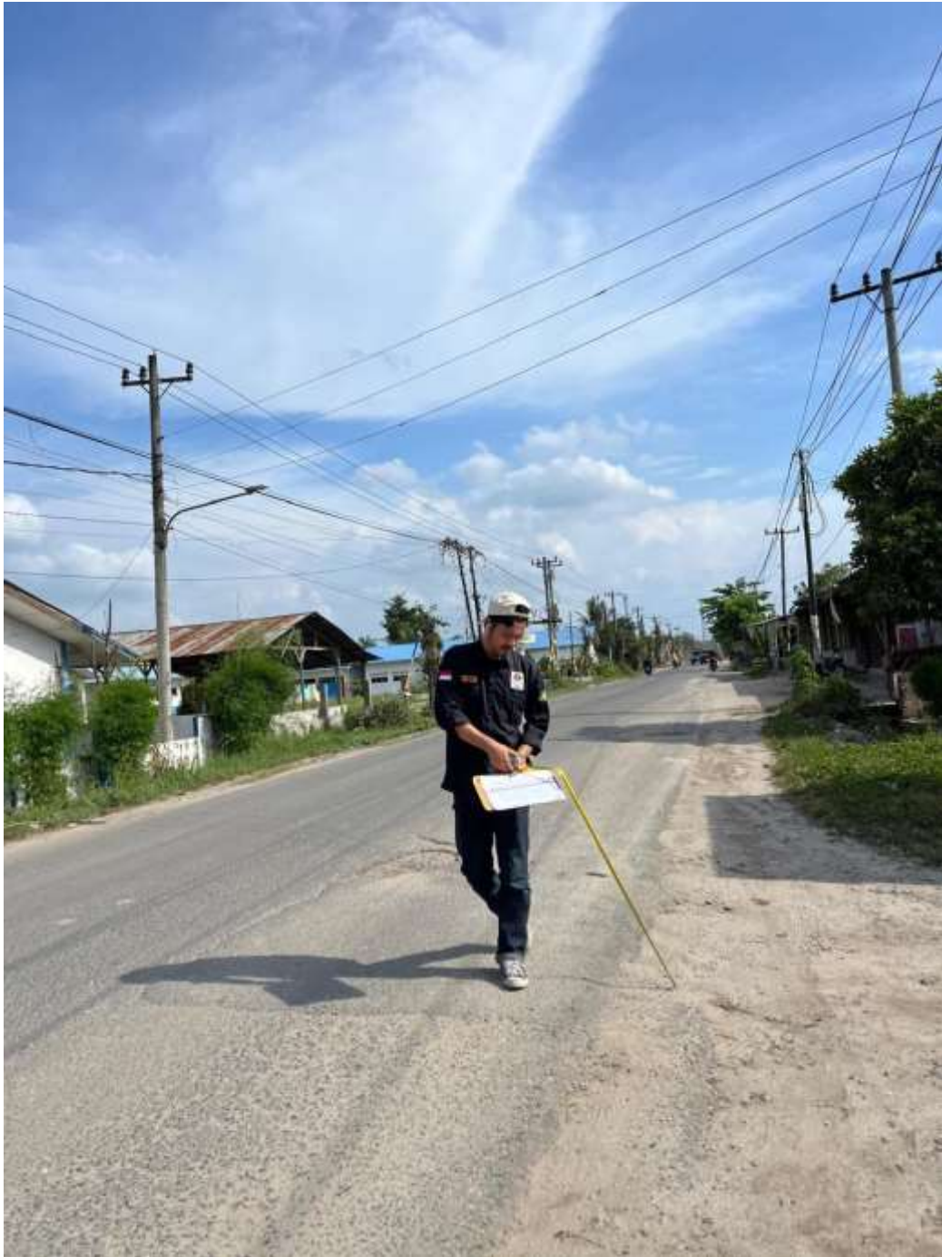
Gambar 2 Menghitung Kerusakan Jalan Jenis Retak Memanjang Dan Melintang
