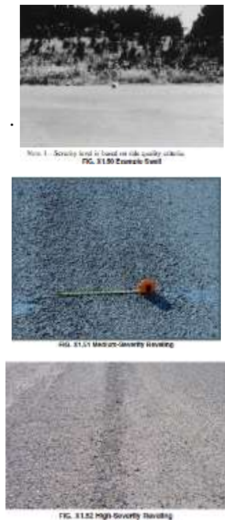
Gambar 2.22 : Contoh kerusakan mengembang jembul ( Swell )
