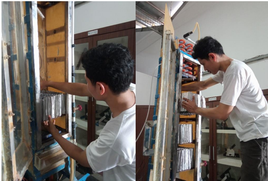
Gambar 4. 8 Pemasangan fill honeycomb pada wet cooling tower
