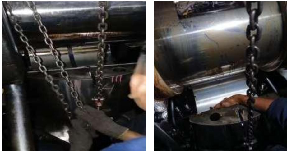
Gambar 4.5 Proses Pembongkaran Lower Bearing Crosshead (PT.WSI)
