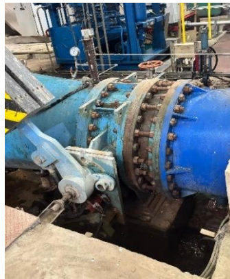
Gambar 2. 9 Main Inlet Valve PLTM Karai 7 (Dokumen Pribadi)
