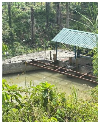
Gambar 2. 15 Saluran Pembuangan PLTM Karai 7 (Dokumen Pribadi)
