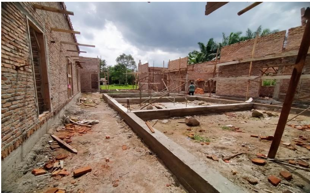
Gambar 2. Pemasangan Dinding Batu Bata
