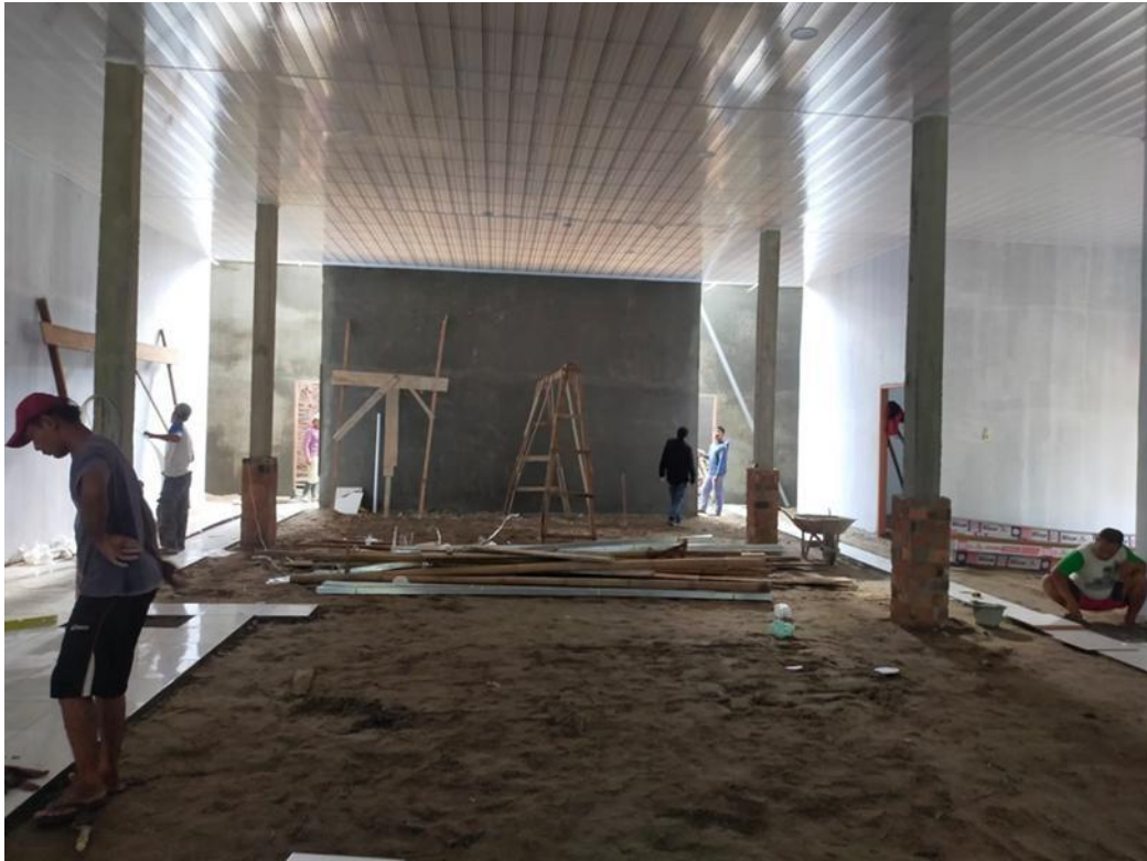
Gambar 3. Pemasangan Plafon PVC
