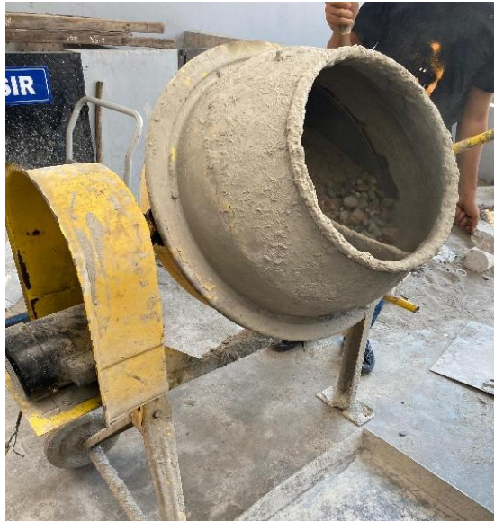
Gambar L.1: Proses pembuatan beton.
