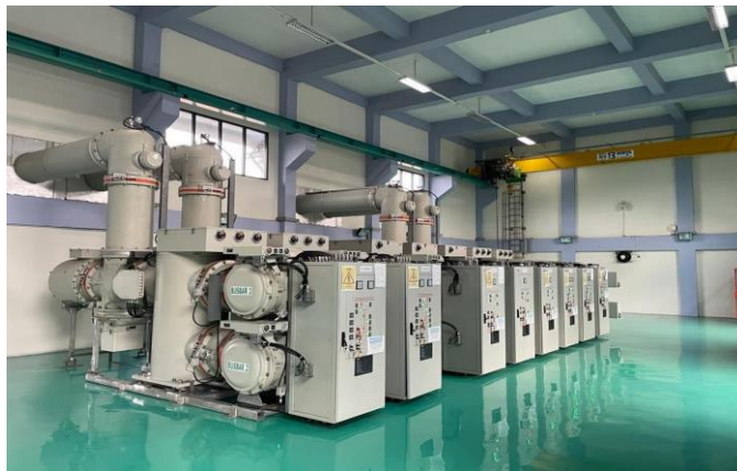
Gambar 2. 2 Gardu Induk Pasangan Dalam
