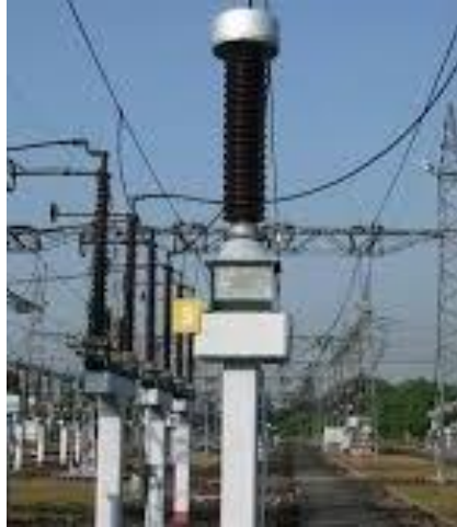
Gambar 2. 11 Trafo tegangan
