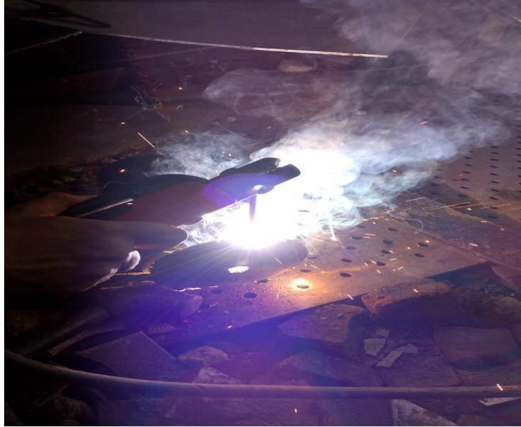
Gambar 4. 43 Pengelasan atau penyambungan bagian atas tabung
