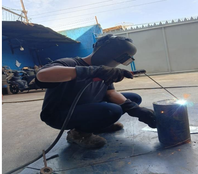
Gambar 4. 41 Pengelasan atau penyambungan alas tabung dengan pipa Carbon Steel
