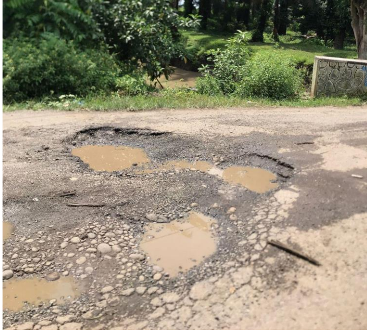
Gambar L.3: Jalan berlubang serta genangan air
