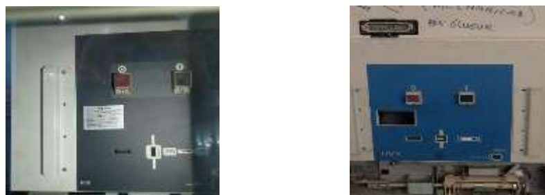
Gambar 4. 2 CB Posisi Normal dan Trip pada Gardu Induk Glugur
