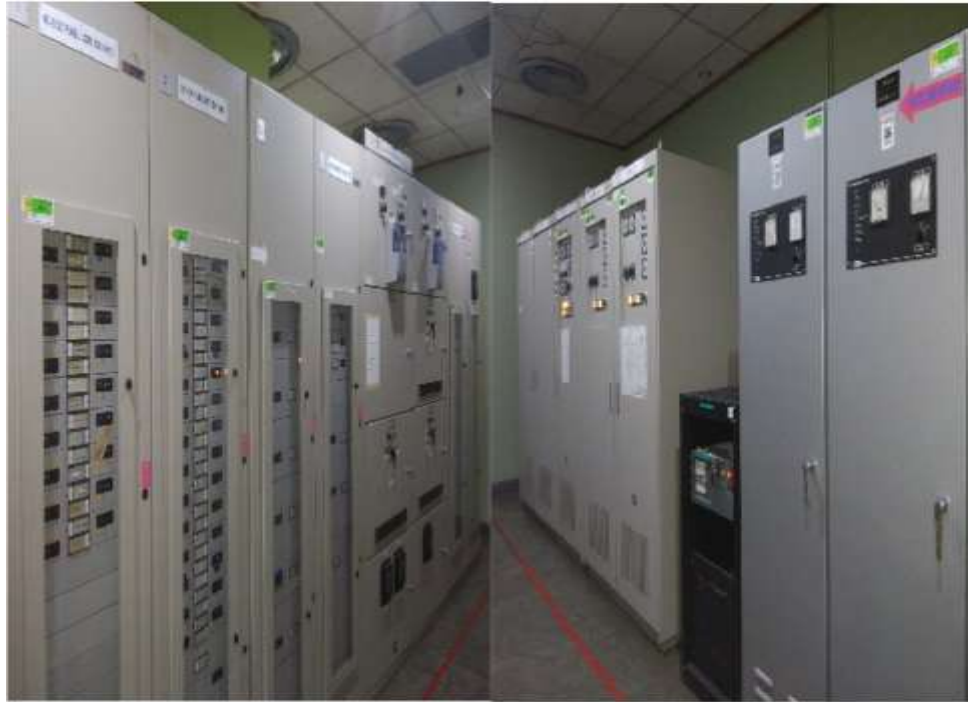
Gambar 2.16 Panel AC/DC Gardu Induk
